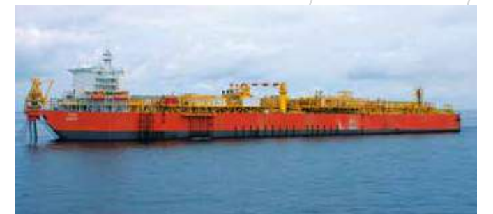
Travaux de sablage et peinture sur la coque et les ballasts d'eau
